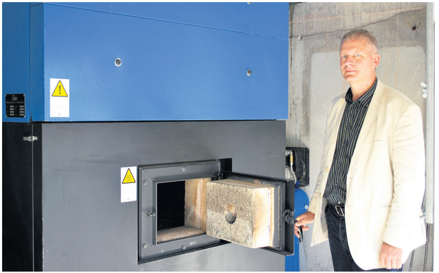
Melchior Tommaso, intendant du site de Marcelin, présente la fameuse chaudière. Une installation de grande envergure, qui permet de réaliser d'importantes économies d'énergie, mais dont la concrétisation n'a pas été aisée! Brun
